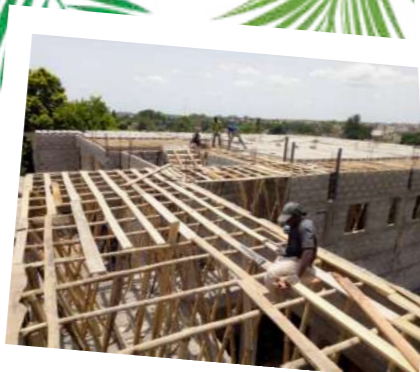
Travaux de l'hôpital de Kétou
